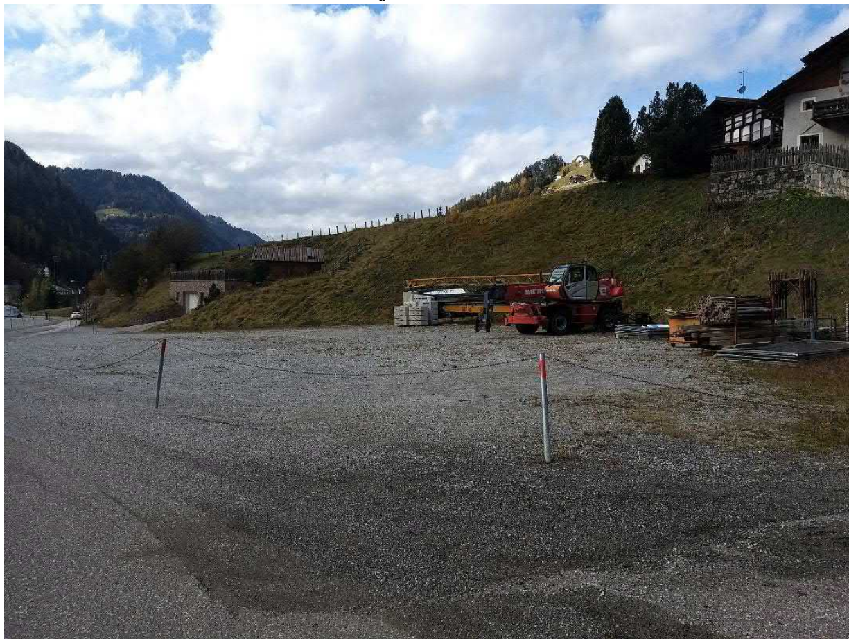
Foto 3 Bereich Talstation und Stützen R1 und S2
