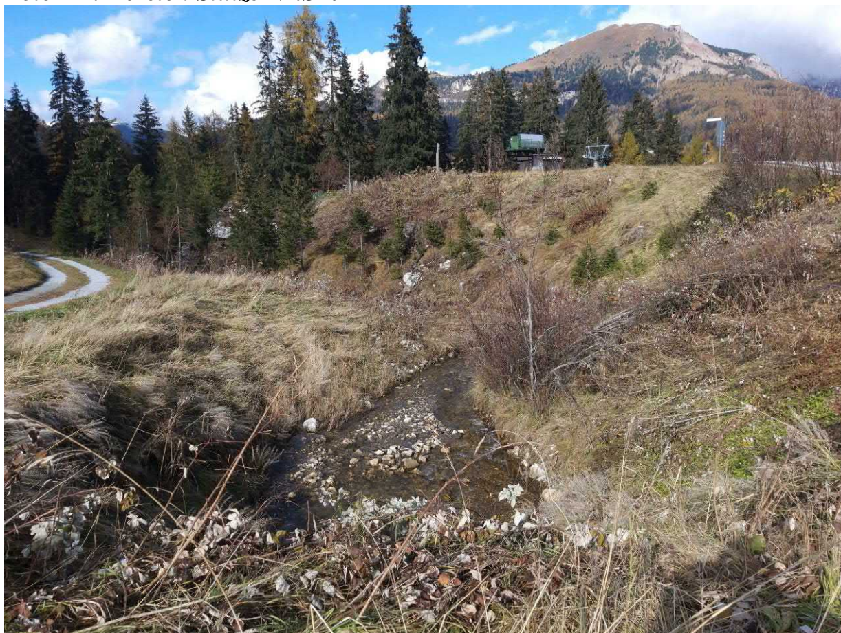
Foto 12 : Bereich Stütze Nr.S10
