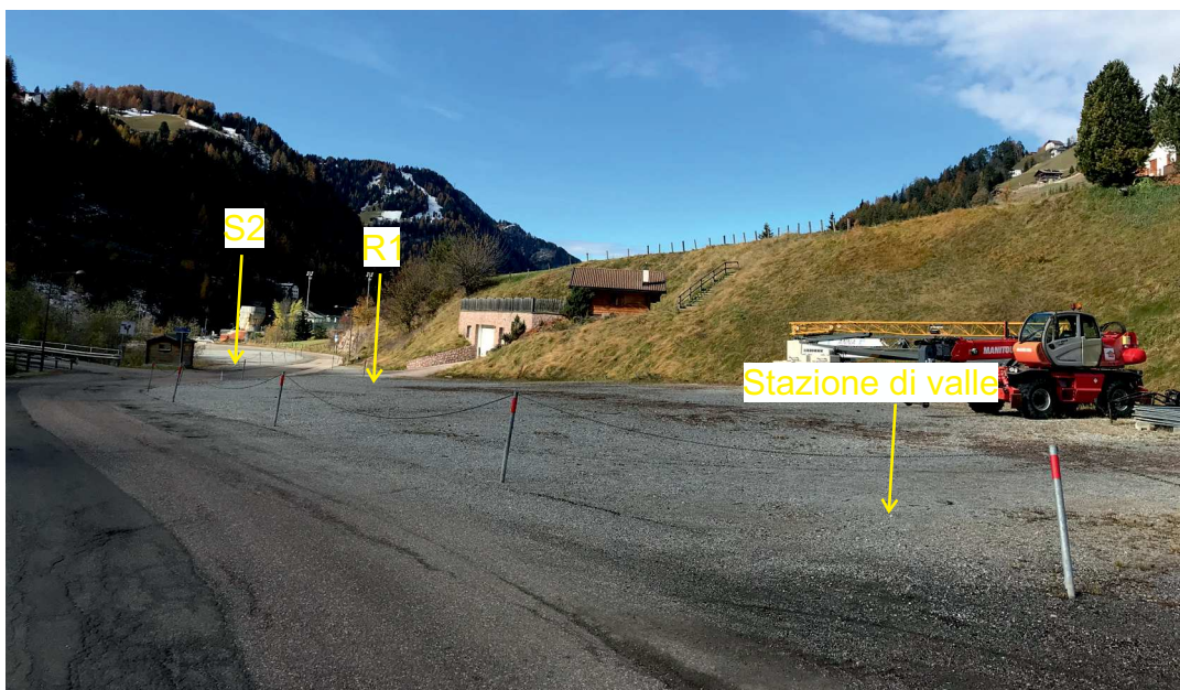
Vista della futura area interessata dalla stazione di valle e dai sostegni R1 e S2.
