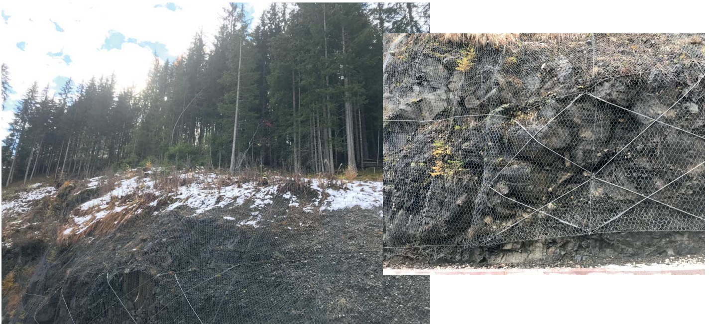
Area di progetto interessata dal sostegno S5 a monte della strada comunale «Str. Pana» con particolare del consolidamento della parete rocciosa.
