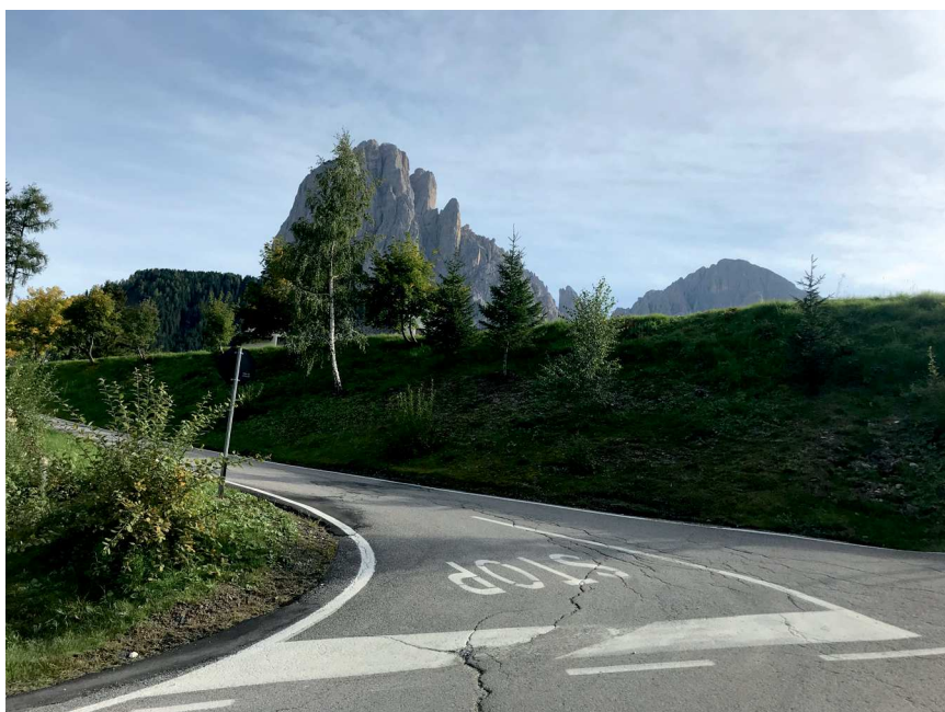
Vista dell'area interessata dal sostegno in progetto S9. L'opera in progetto sarà posta tra il piazzale soprastante e la sede stradale.
